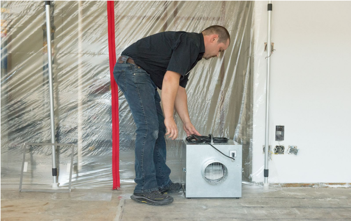
ToolPower Staubfänger – Luftreiniger aufstellen, Magnetraumen anbringen und einschalten
