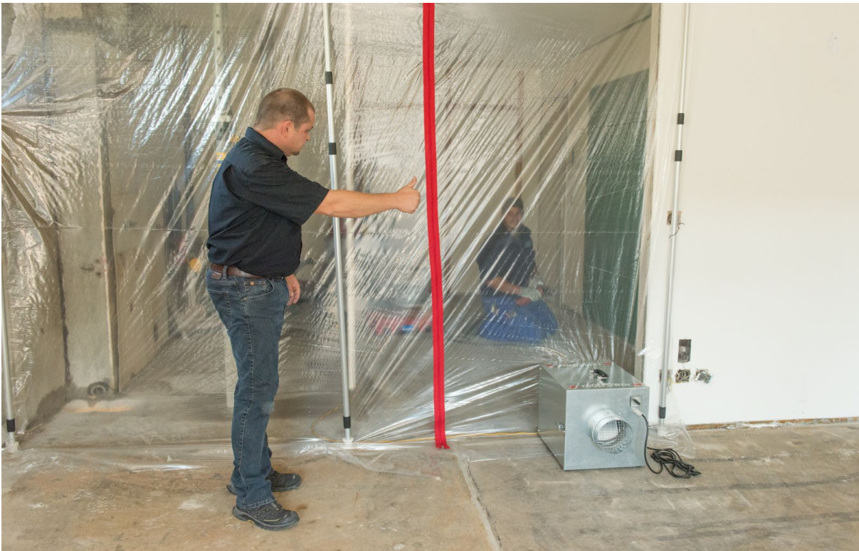
ToolPower Staubfänger – Luftreiniger aufstellen, Magnetraumen anbringen und einschalten
